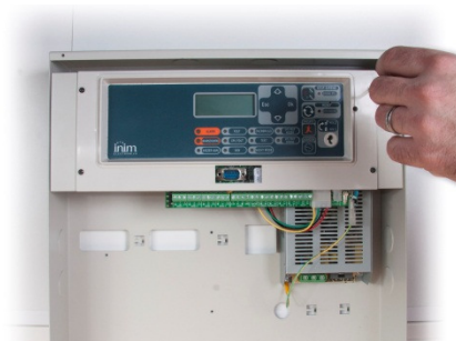
Schroef de vier schroeven los van het bedieningspaneel
