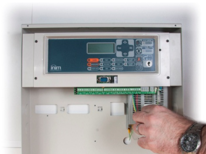
Haal de voedingsconnector los van het bedieningspaneel
