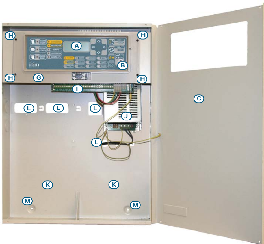
Afbeelding 5 - Binnenkant van de SmartLine036
